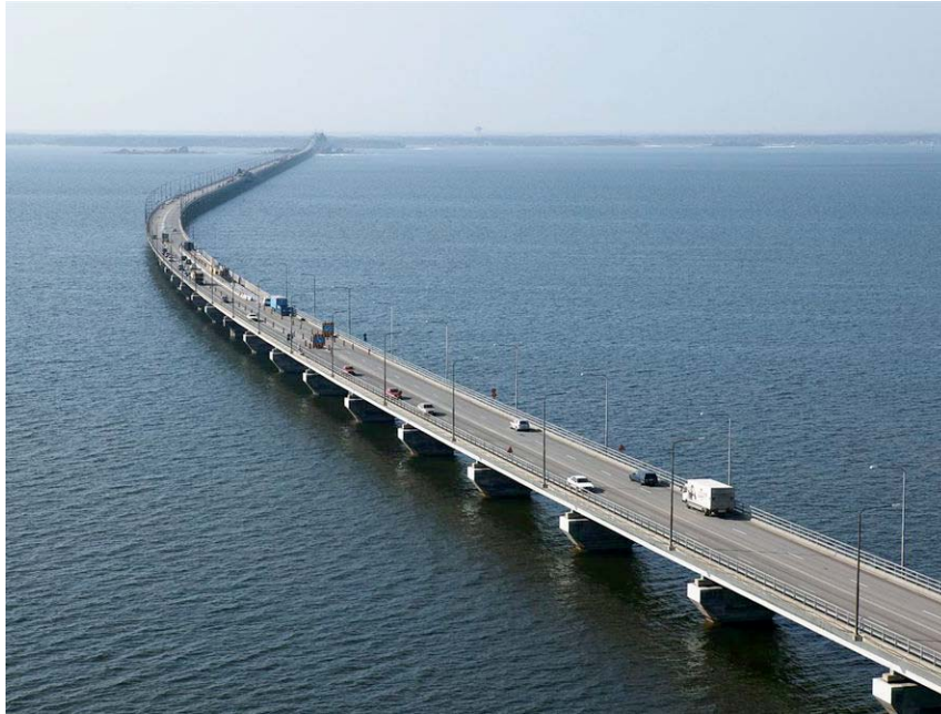
Figur 11: Ölandsbrons lågbro del.
